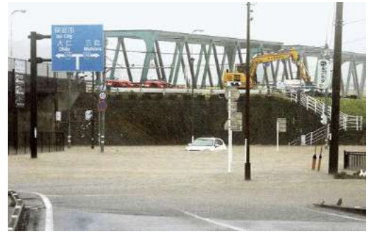
2019年の浸水被害（伊豆の国市） 静岡新聞より
